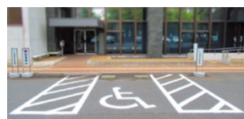
車いす使用者用駐車施設
